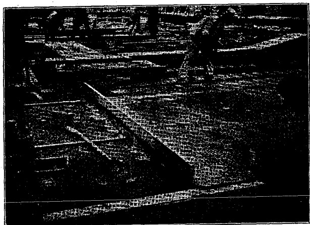
Fig. 907. Afretning af Mørtelslidlag.
